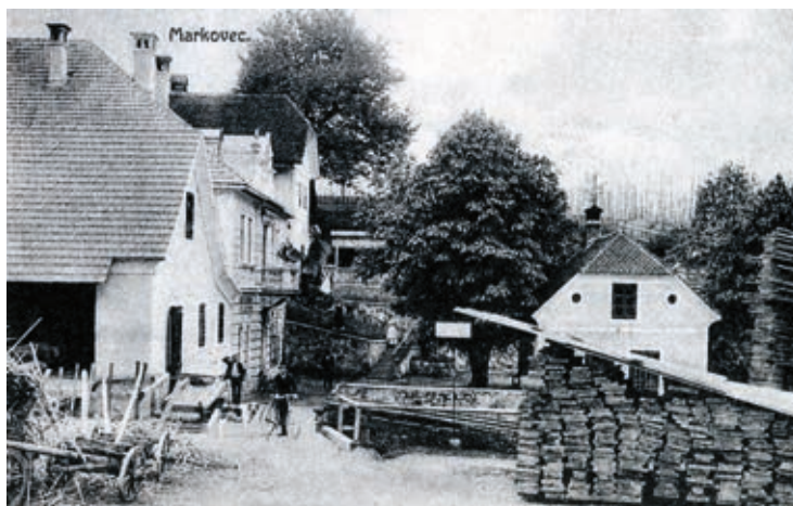
Gospodarske in bivalne stavbe pri Špetnaku v Markovcu. Žaga je bila v stavbi na levi, v stavbi za njo so bila stanovanja, v stavbi za skladišnico desk pa pisarna (M. Žagar, Dva brata, trije svetovi, Ljubljana 2015, str. 15)
